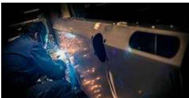
Lassen van een chassis
